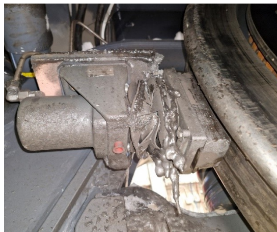
Obr. 20 Poškozený měch čistící jednotky
