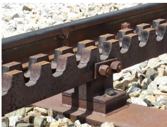
Obr. 2 Systém dvoulamelové Abtovy ozubnice na ozubnicové dráze Schneebergbahn v Rakousku
