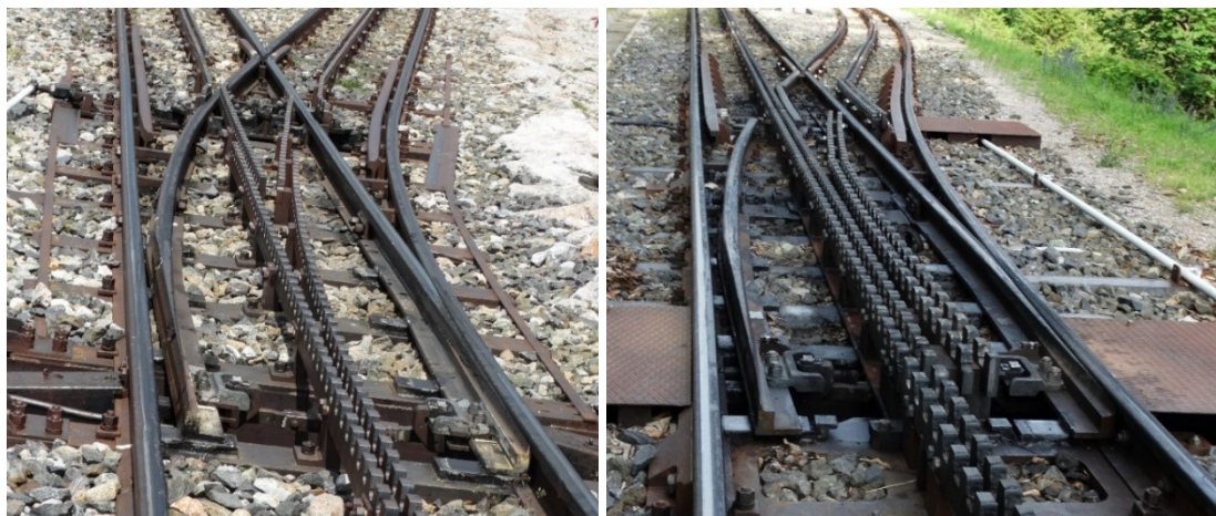
Obr. 3 Porovnání typů výchybek pro systém Abtovy ozubnice – typ II (vlevo) a typ V (vpravo). Výchybky vyfoceny na ozubnicové dráze Schneebergbahn v Rakousku
